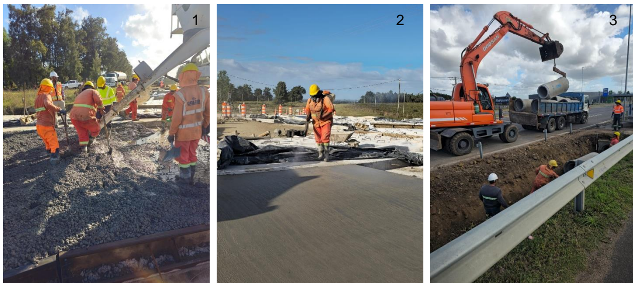
1 y 2: Rotonda en hormigón. 3: Alargue de alcantarillas.
