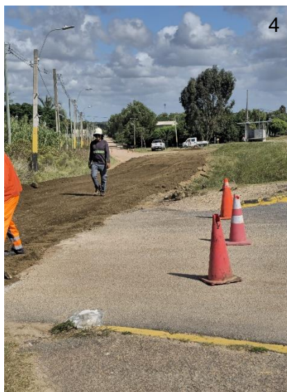
4, 5 y 6: Recargo de base Registro fotográfico realizado por personal de Colier en febrero de 2026
