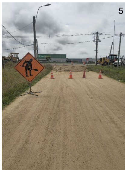
4, 5 y 6: Recargo de base Registro fotográfico realizado por personal de Colier en febrero de 2026
